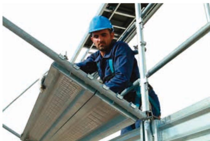
57 • detal montażu desek do osłony odpryskowej
