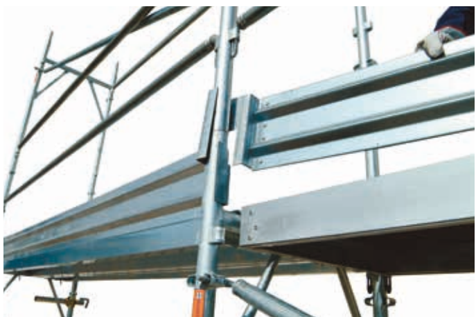
36 • detal bortnicy na poziomie 1
