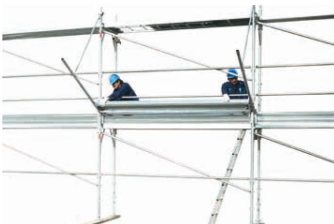
55 • montaż desek do osłony odpryskowej
