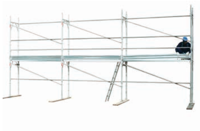
38 • montaż bortnicy na poziomie 1
