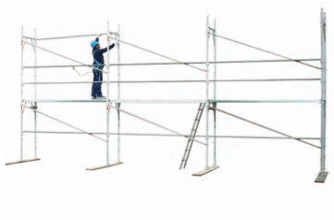
34 • montaż poręczy tylnej na poziomie 1
