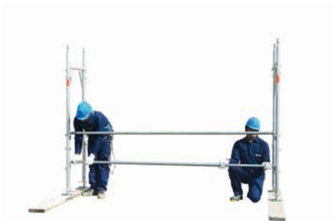
6 • montaż drugiej poręczy
