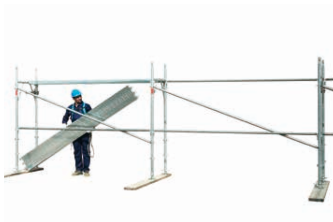
17 • montaż płyt stalowych
