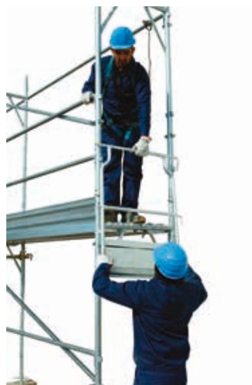
39 • montaż balustrady czołowej na poziomie 1
