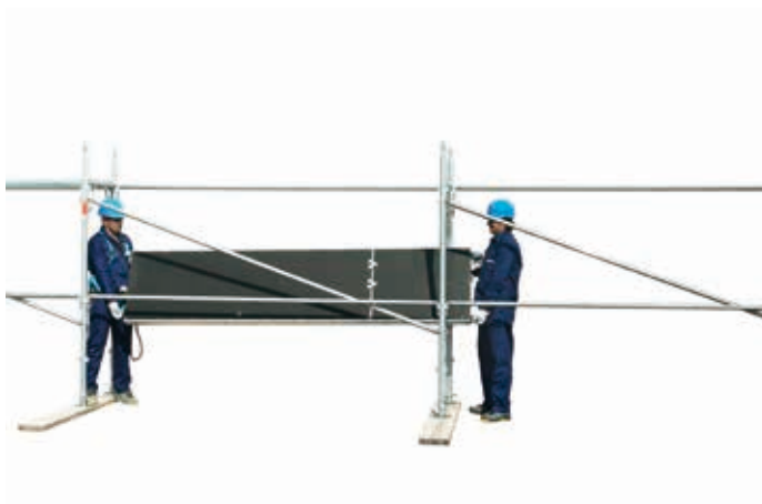
18 • montaż płyty z włazem
