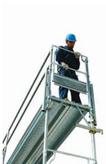
51 • montaż balustrady czołowej na poziomie 2
