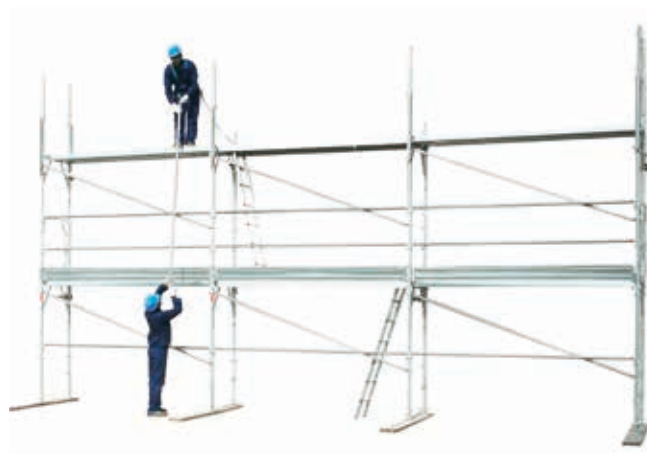
50 • montaż poręczy i valustrad na poziomie 2
