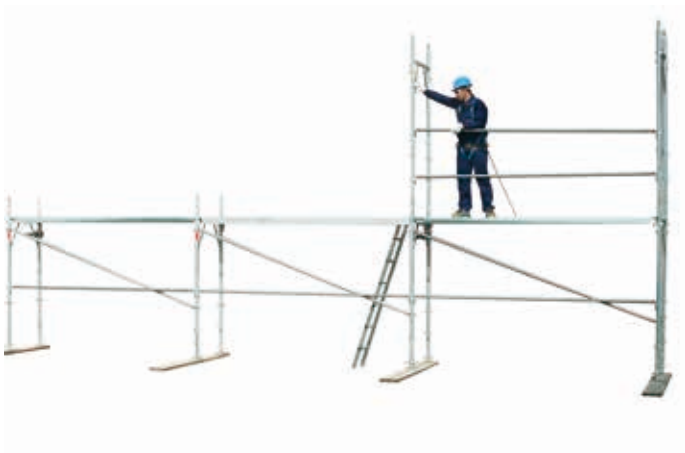
31 • montaż balustrady na poziomie 1
