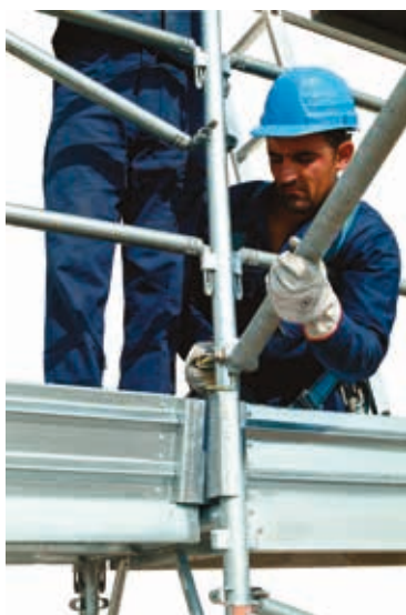
54 • detal wspornika osłony odpryskowej
