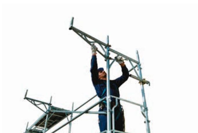
58 • montaż wspornika i stężenia wspornika
