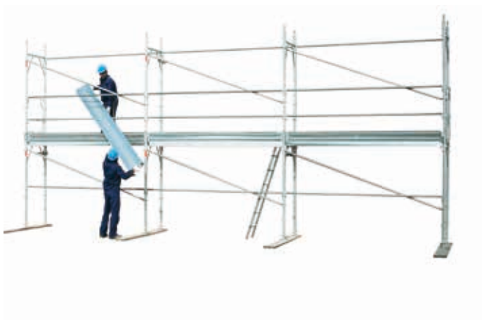
42 • montaż płyt na poziomie 2
