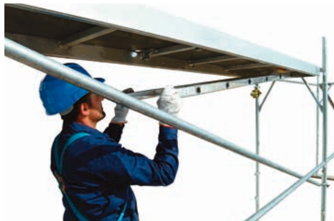
21 • wsunięcie drabinka płyty z włazem
