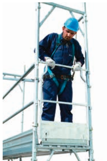
40 • montaż balustrady czołowej na poziomie 1
