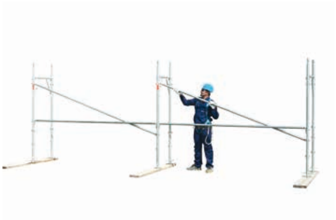
12 • montaż następnego modułu
