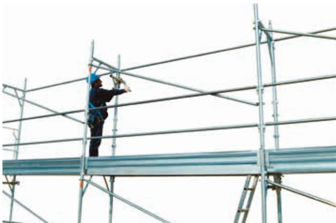
41 • montaż kotwienia na poziomie 1 o ile wymagane
