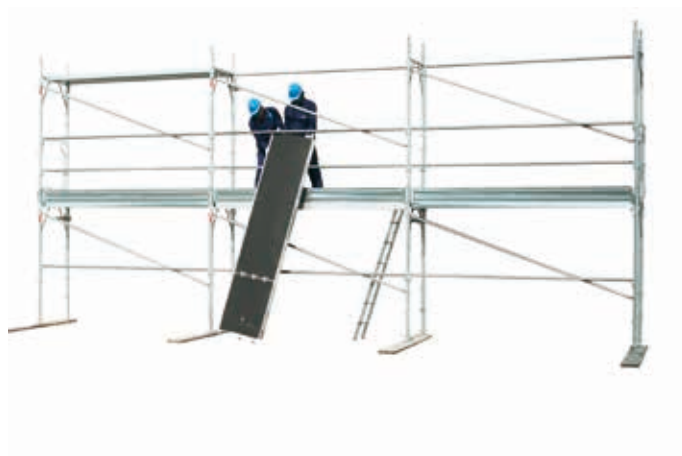
44 • montaż desek z włazem na poziomie 2
