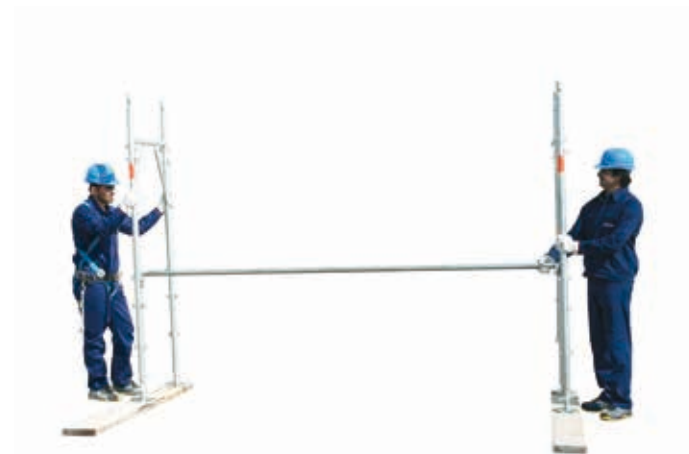
5 • montaż drugiej ramy wraz z balustradą
