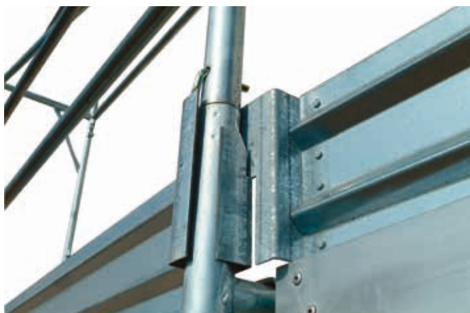
37 • detal bortnicy na poziomie 1
