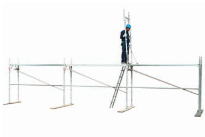
27 • montaż ramy na poziomie 1
