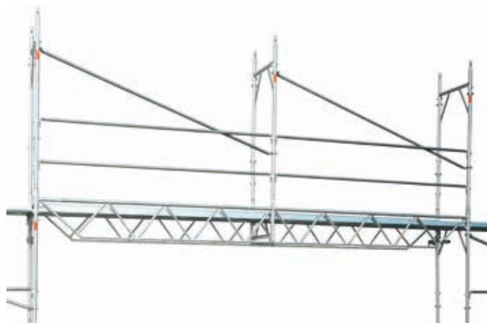
70 • koniec montażu nad wiazarami przejazdowymi
