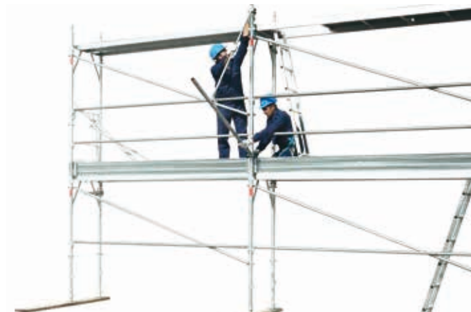
52 • montaż wspornika osłony odpryskowej
