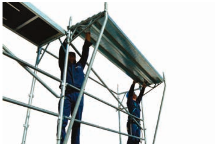
62 • montaż desek na wsporniku
