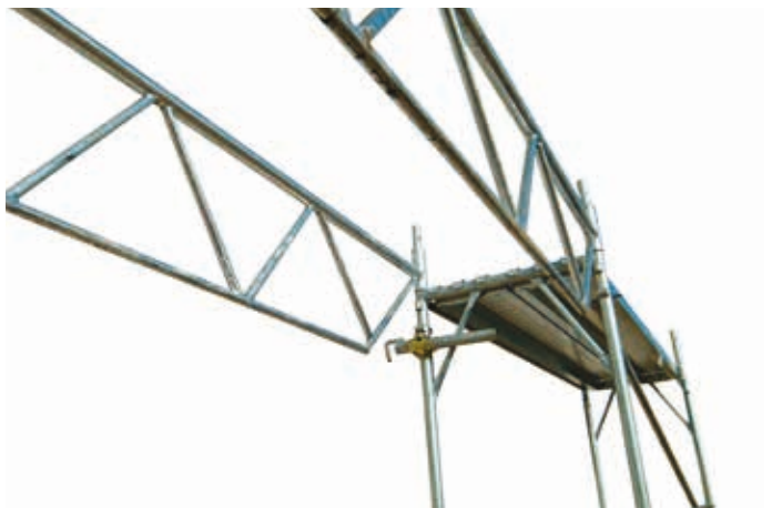
65 • montaż wiazara przejazdowego
