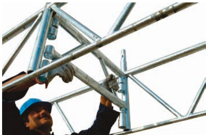
66 • montaż belek łącznikowych wiazara przejazdowego
