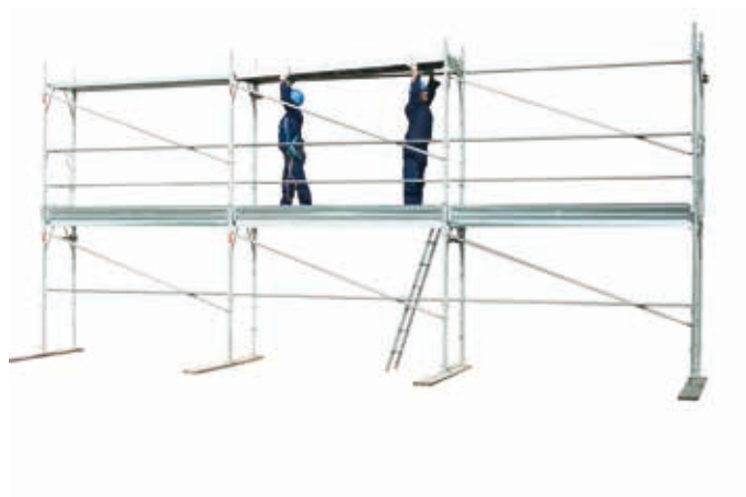
45 • montaż desek z włazem na poziomie 2
