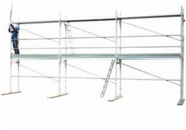
47 • montaż stojaka krańcowego na poziomie 2
