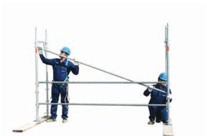
7 • montaż stężenia poziomego
