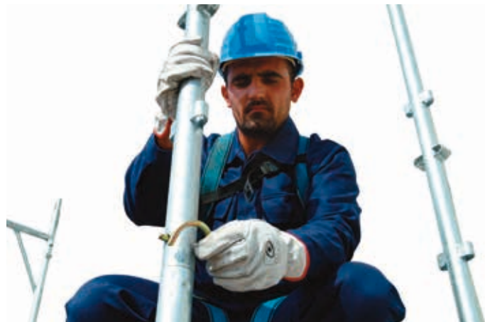
29 • montaż kołków ramy
