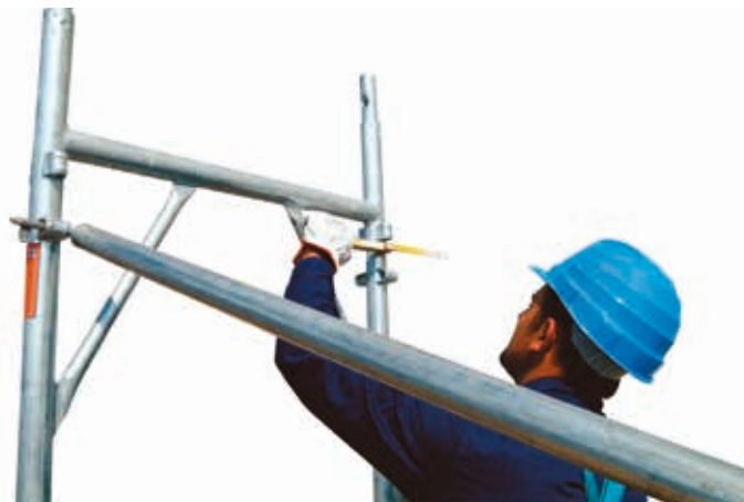
9 • sprawdzenie odległości od elewacji
