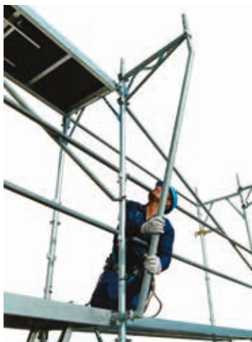
59 • montaż stężenia wspornika
