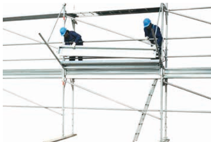
56 • montaż desek do osłony odpryskowej
