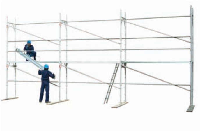
35 • montaż bortnicy na poziomie 1
