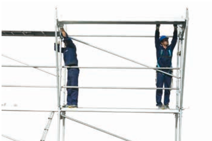
61 • montaż desek na wsporniku
