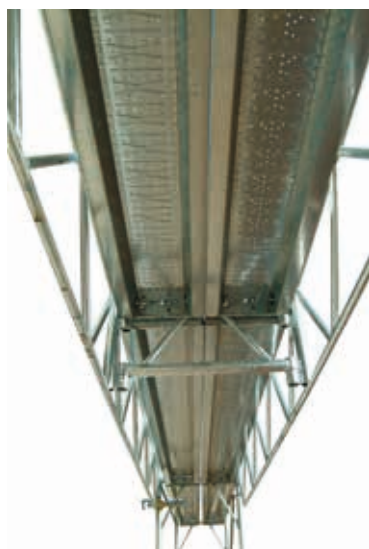
67 • montaż podestu na wiazarach na d przejazdem
