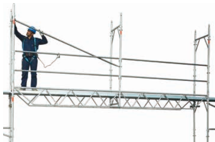
69 • montaż stężeń poziomych nad wiazarami przejazdowymi
