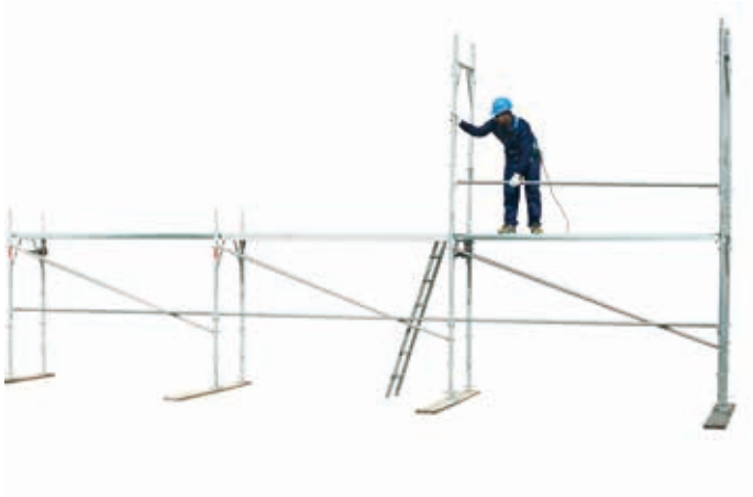
30 • montaż poręczy na poziomie 1
