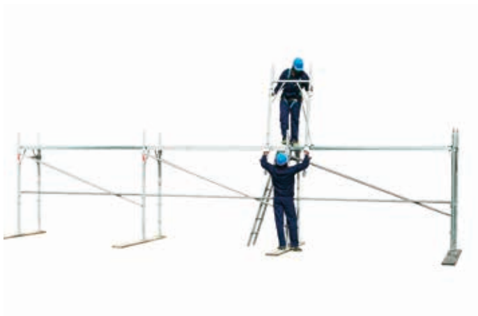
26 • początek montażu ram na poziomie 1
