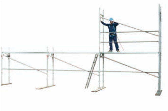
32 • montaż stężenia poziomego na poziomie 1
