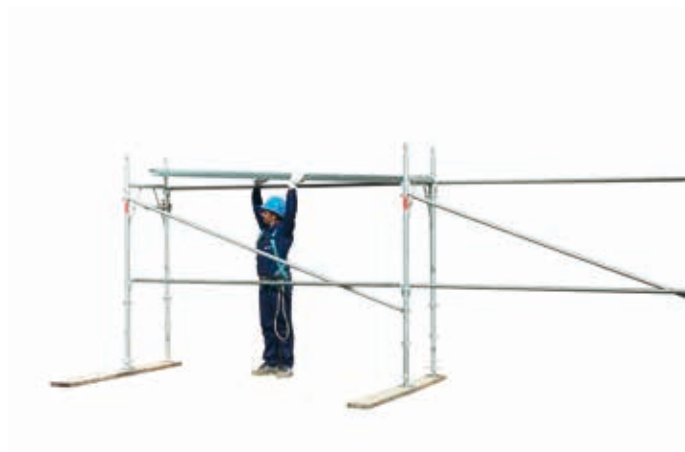
16 • montaż płyt stalowych
