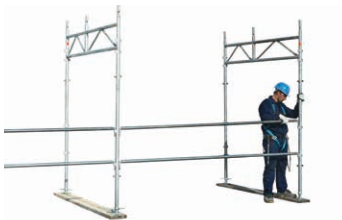
63 • montaż połączeń ramy nadchodnikowej
