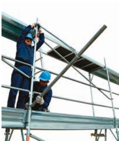
53 • dettaglio parasassi
