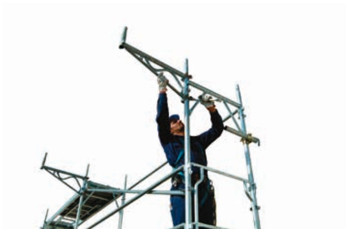
58 • montaggio mensola con puntone
