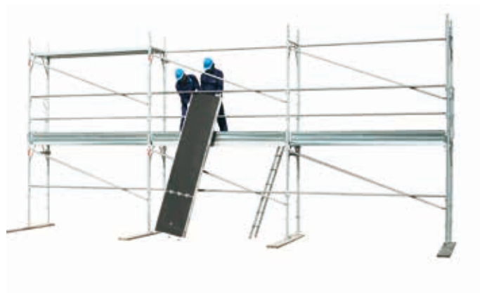
44 • montaggio tavole con botola al livello 2
