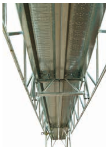
67 • montaggio impalcato sulle travi carraie
