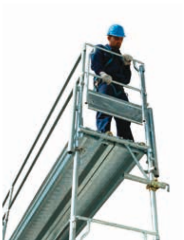
51 • montaggio parapetto di testata al livello 2
