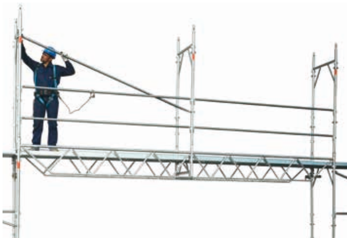
69 • montaggio diagonali in vista sopra le travi carraie
