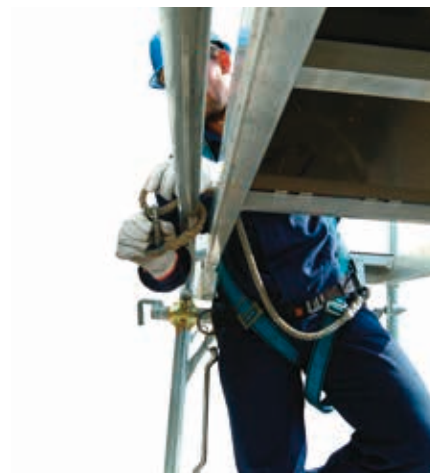
24 • collegamento della fune di trattenuta prima di salire al piano
