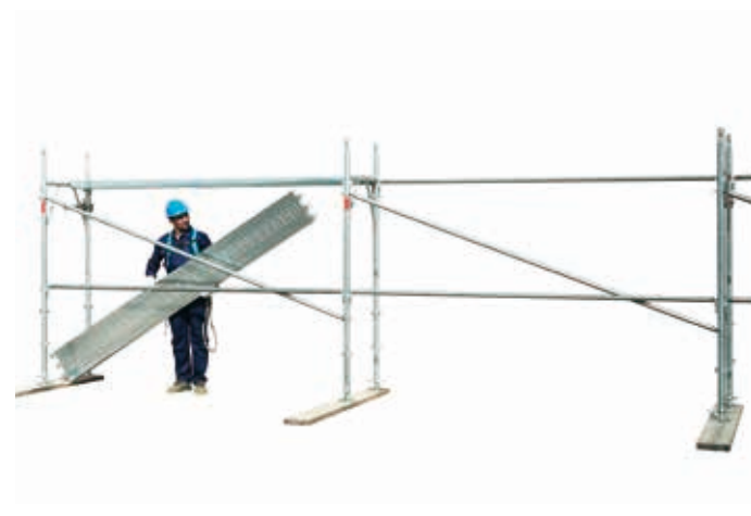
17 • montaggio tavole metalliche
