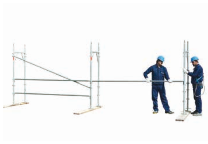
11 • montaggio moduli successivi
