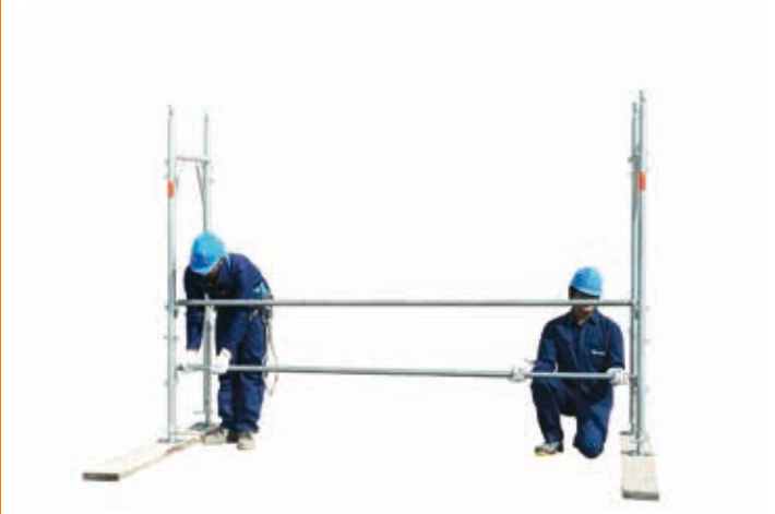
6 • montaggio secondo corrente
