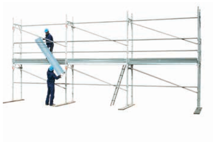
42 • montaggio tavole al livello 2
