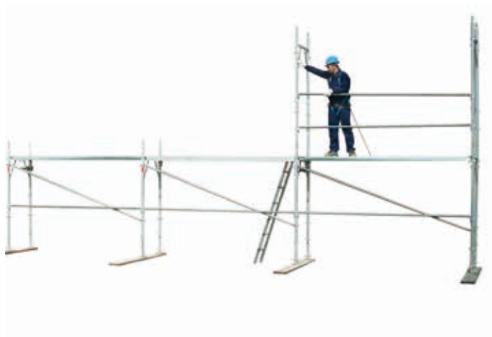
31 • montaggio parapetto al livello 1
