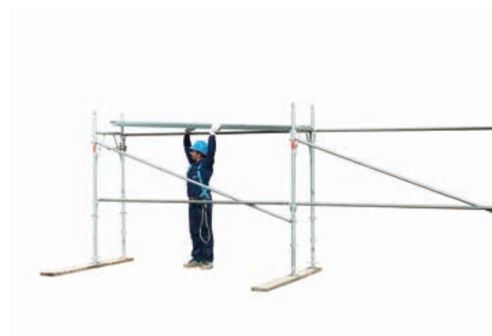
16 • montaggio tavole metalliche
