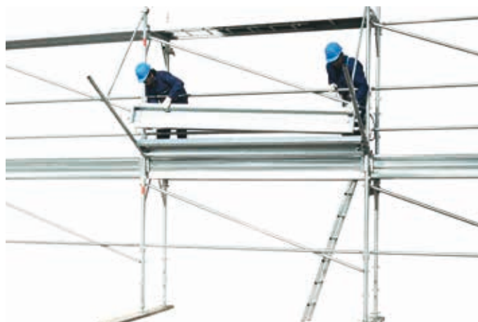
56 • montaggio tavole del parasassi
