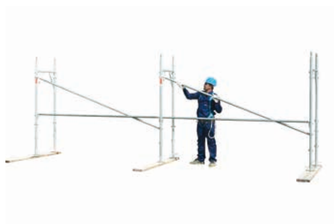
12 • montaggio moduli successivi
