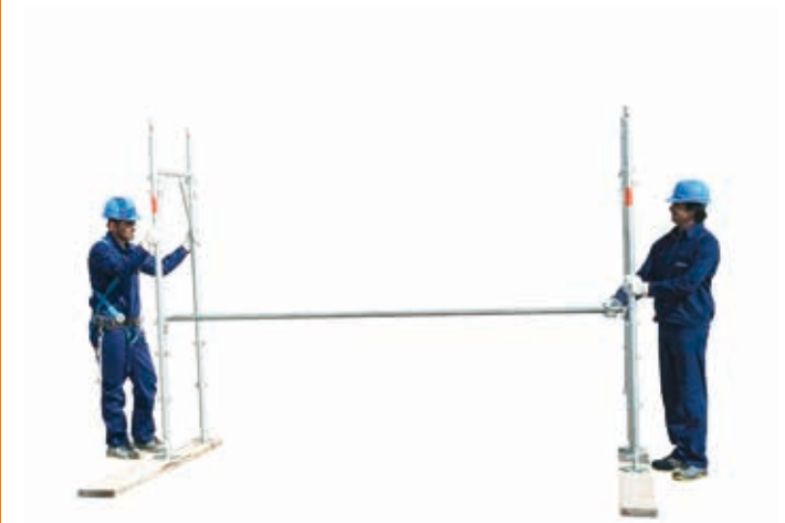
5 • montaggio secondo telaio con parapetto
