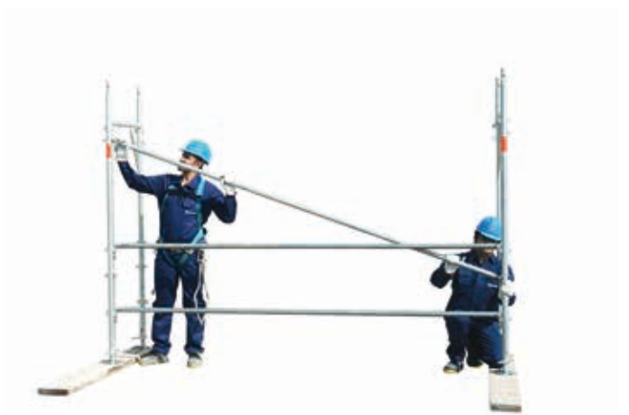
7 • montaggio diagonale in vista
