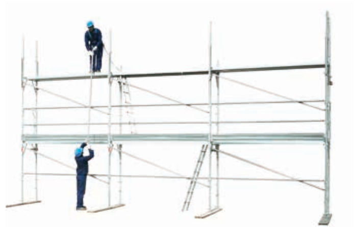
50 • montaggio correnti e parapetti al livello 2
