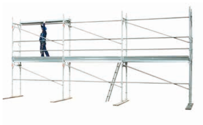
43 • montaggio tavole al livello 2
