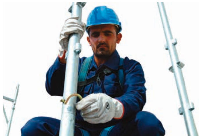
29 • montaggio spine dei telai
