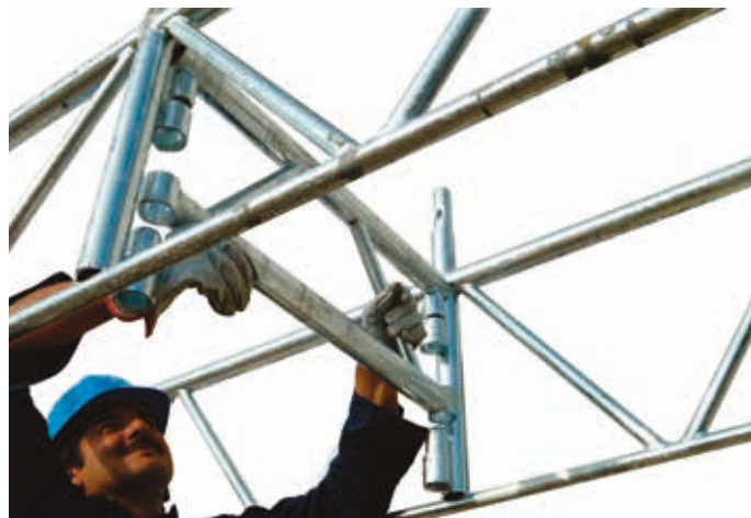
66 • montaggio trave di collegamento delle travi carraie
