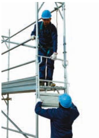
39 • montaggio parapetto di testata al livello 1
