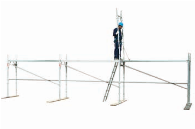
27 • montaggio telaio del livello 1
