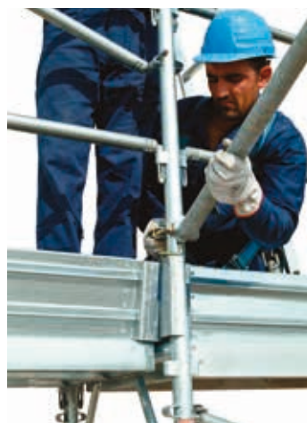
54 • dettaglio parasassi
