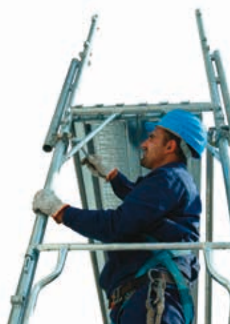
48 • serraggio giunto del montante di sommità al livello 2
