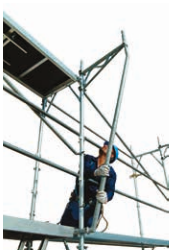
59 • montaggio puntone della mensola
