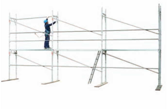
34 • montaggio corrente posteriore al livello 1
