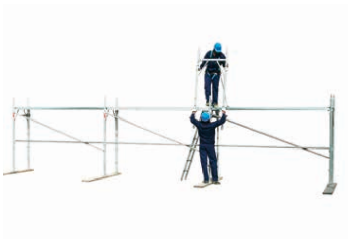
26 • inizio montaggio telai del livello 1
