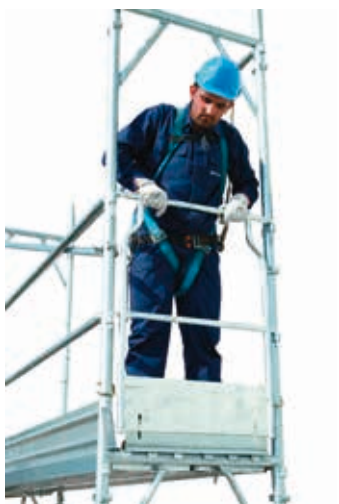
40 • montaggio parapetto di testata al livello 10
