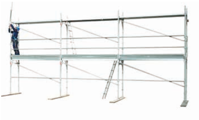
47 • montaggio montante di sommità al livello 2
