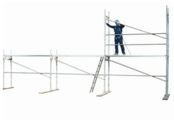
32 • montaggio diagonale in vista al livello 1
