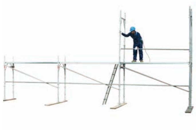
30 • montaggio corrente al livello 1
