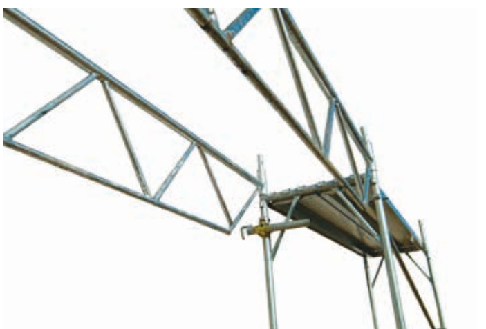
65 • montaggio trave carraia
