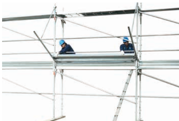
55 • montaggio tavole del parasassi
