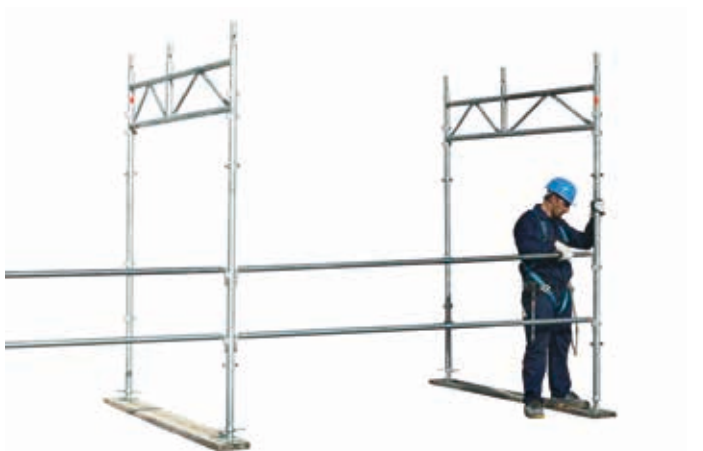
63 • montaggio collegamenti del telaio passaggio pedonale
