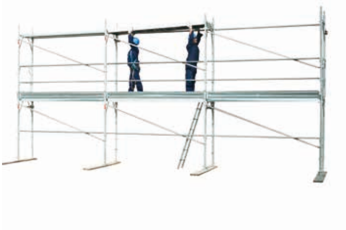
45 • montaggio tavole con botola al livello 2
