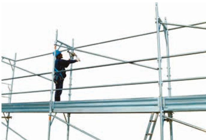
41 • montaggio ancoraggio al livello 1 ove richiesto
