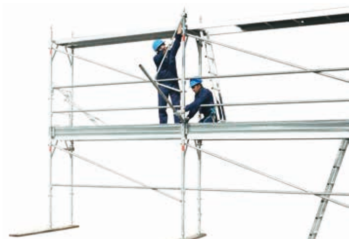
52 • montaggio parasassi
